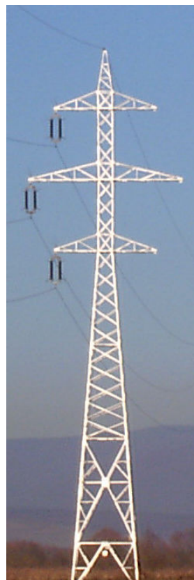
1.12. ábra. Az elmozdulás-módszerrel elemezhető rácsos szerkezet
