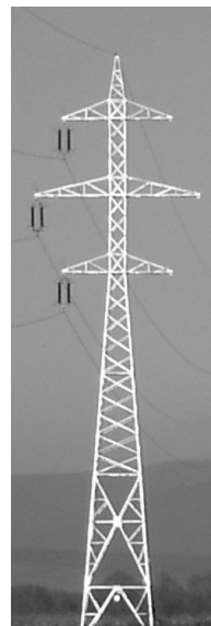
1.11. ábra. Az elmozdulás-módszerrel elemezhető rácsos szerkezet
